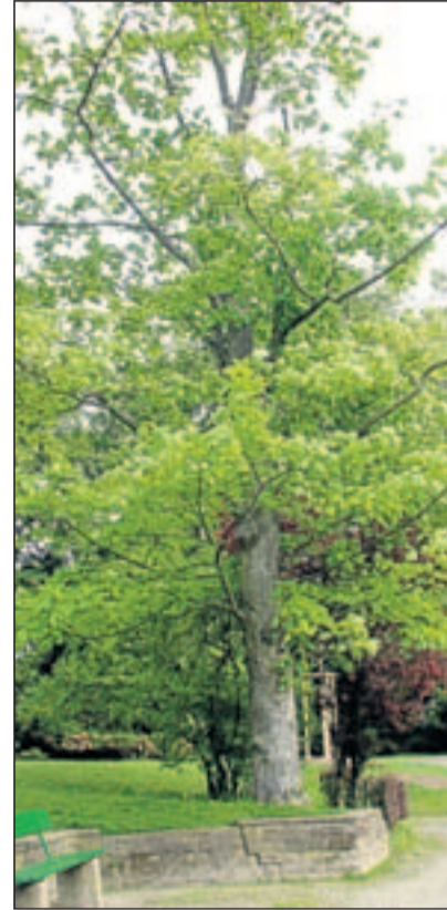
Zerstört die Stützmauer und hat selbst Versorgungsprobleme: der Ahorn am Entenfütterplatz.
